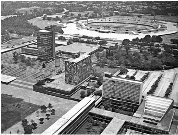
Vista aérea de Ciudad Universitaria, obra emblemática de integración plástica inaugurada en 1952, al sur de la capital mexicana.
